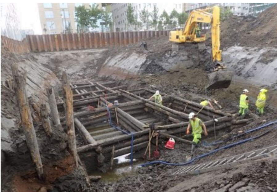
Figur 9. Bålverk på B3/B7 2016. Ett 0,5 meter tjockt sågflislager från 1700-talet är synligt som en brun rand i de snedställda schaktkanterna.
