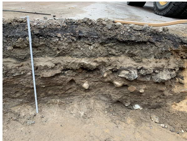
I schaktets norra kant syntes horisontella lager och två stenläggningar som föregått dagens Östra Kyrkogata. Foto: Ellinor Larsson, Värmlands Museum.
