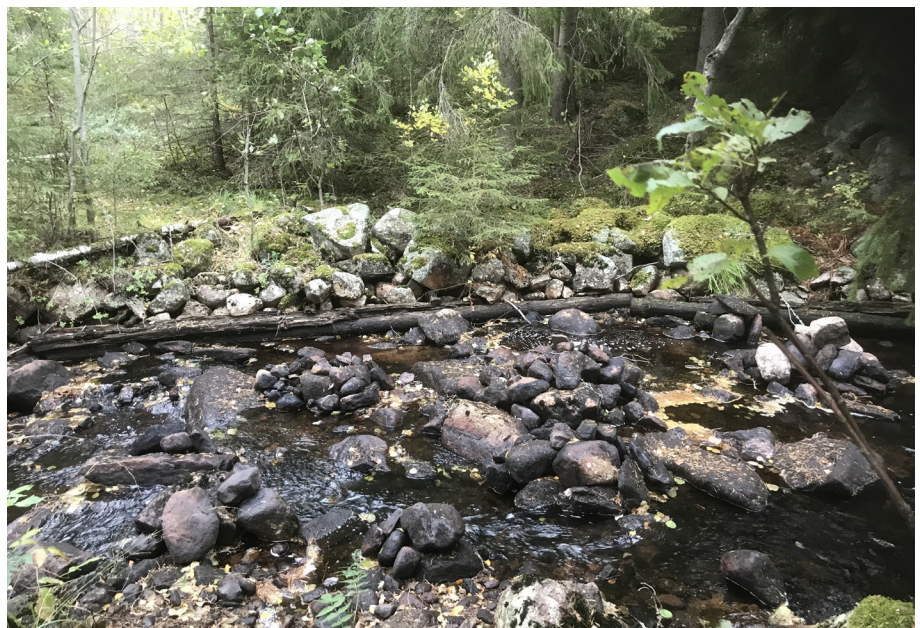
Figur 7. Enkelkista i strandkanten samt skapade ståndplatser för fisk i vattendraget. Foto av Björn Wallbom, Länsstyrelsen Värmland.
